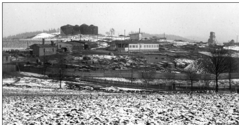
Foto: staveniště pevnosti, r. 1938, archiv R.Švandy
