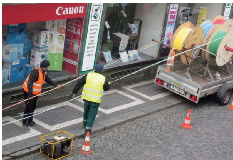
Zatímco před sto lety předávaly informace dráty telegrafního vedení, náš moderní svět stěhuje informační toky pod zem. Na snímku pokládání optických kabelů v Náchodě. Foto echo
