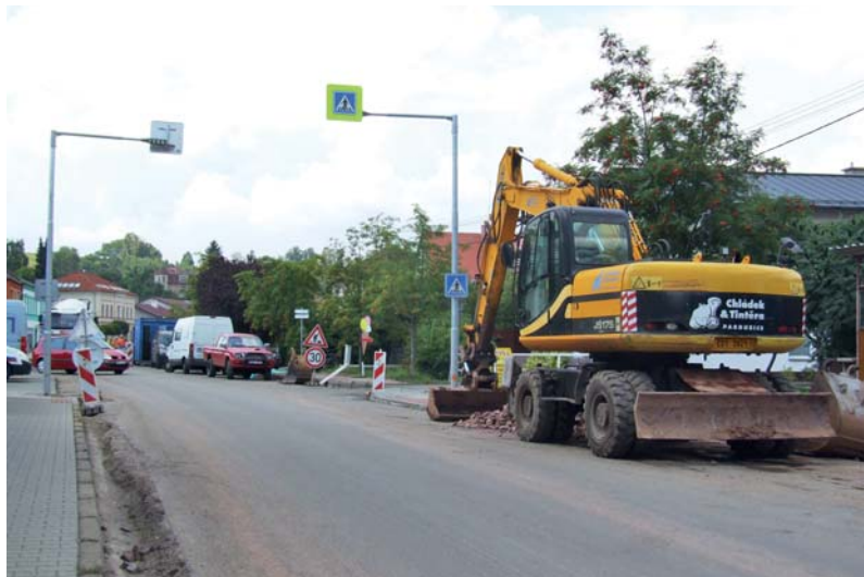
Do 7. září by měly trvat práce na opravách silnice procházející Dolní Radechovou. Doprava mimo osobní dopravu občanů obce, vozidel zásobování či veřejné dopravy je odklášlena mimo Dolní Radechovou. foto echo
