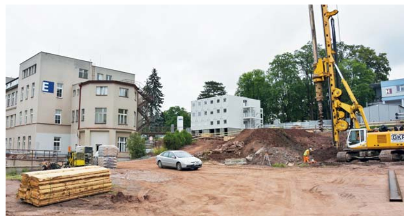
Po demolicí nevyhovujících objektů jsou v plném proudu zemní práce.
