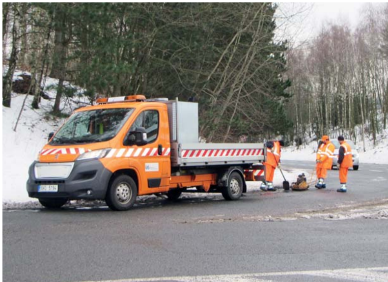
Cestáři budou mít samozřejmě hodně práce na jaře, až budou sčítat škody, které na silnicích napáchala zima. Přesto je nutné, aby byly některé nejhorší sráhy na povrchu vozovek zaceleny i v aktuálním čase. Náš redakční fotoaparát zachytil jednu takovou „cestářskou záchranku“ při práci při výjezdu z Náchoda u obce Vysokov. foto echo
