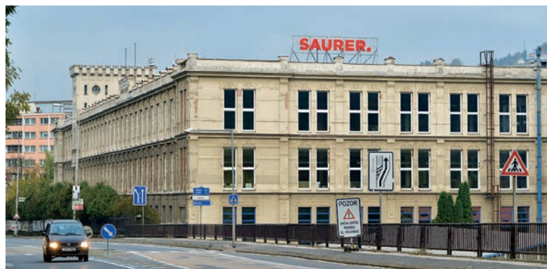
Saurer Czech nově sídlí v Náchodě, Jugoslávské ulici ve třetím patře bývalé Bartoňovy přádelny.
