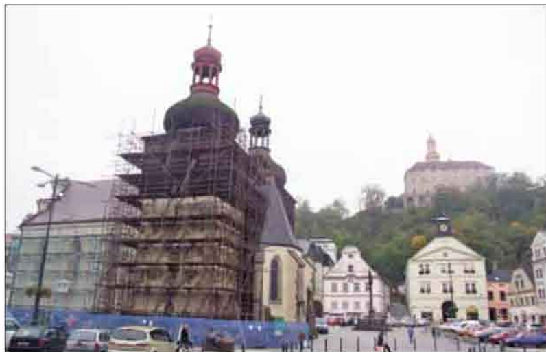
Rekonstrukce kostela sv. Vavřince v Náchodě
