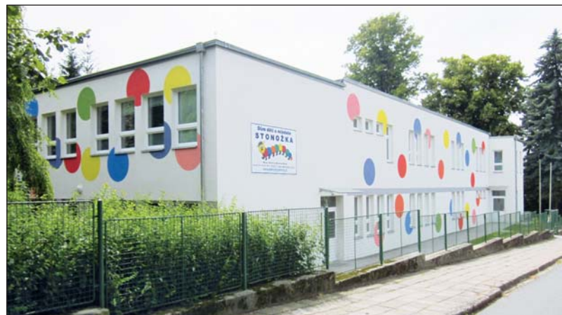
Ředitelka DDM Stonožka Nové Město nad Metují Mgr. Dagmar Rudolfová se pochvalně vyjádřila o spolupráci se společností Průmstav Náchod s.r.o. během rekonstrukce objektu. Vzhledem k tomu, že práce bylo nutno realizovat i v průběhu podzimu a zimy, často stavební činnosti a řemesla komplikoval klimatický faktor. „Zaměstnanci firmy Průmstav vše zvládli a většinou dokonce s úsměvem“, zdůraznila Mgr. Rudolfová.
