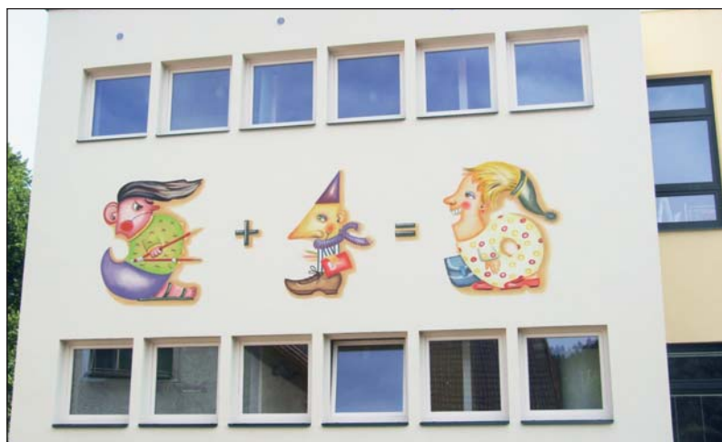
Základní škola 1. Máje v Náchodě prodělala v rámci rekonstrukce i výměnu oken. Celá budova bude mít tak výrazně zlepšené tepelné izolační vlastnosti. Zároveň se snižuje i hlukost ve všech prostorách a zvyšuje celkový komfort pro malé i velké obyvatele.
