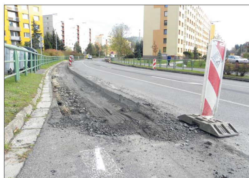
Náchod je v současné době dějištěm mnoha zásahů do dopravního systému včetně rekonstrukcí a oprav silničních komunikací. Stranou nezůstala ani Plhovská ulice, která je důležitou výpadevkou směrem na Trutnov. Foto pro ECHO Josef Pepa Voltr
