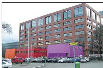
☐ ČVUT Praha - opláštění přístaveb (materiál PREFA)
