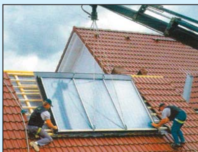
Montáž solárních kolektorů Bramac je rychlá a efektivní.
