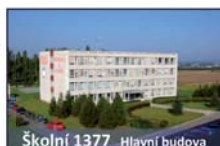
Školní 1377 Hlavní budova
