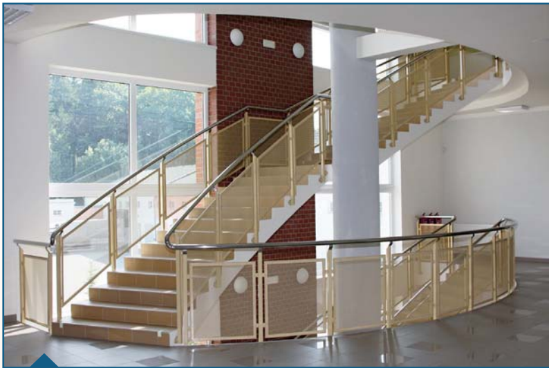
Pro společnost Batist s.r.o. realizoval Průmstav přístavbu školícího centra. V objektu bylo zhotoveno zajímavé schodiště včetně nosného sloupu protínajícího více podlaží.
