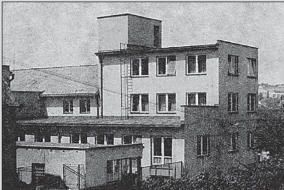
□ Přístavěná provozovna Vzoru v Orlické ulici
