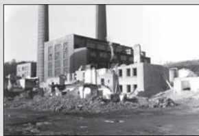
☐ Starší provozní část - bourání Prádnické ulice
