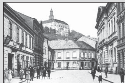
□ Budova Rydlovsky tiskárny vlevo
