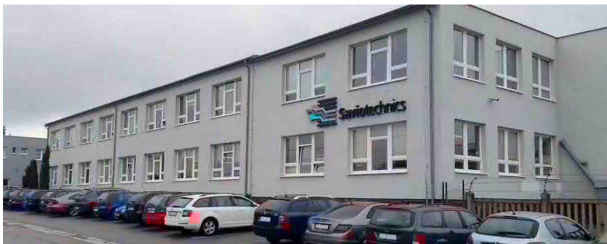
Budova firmy Saviotechnics v Červeném Kostelci – Lhotě.
